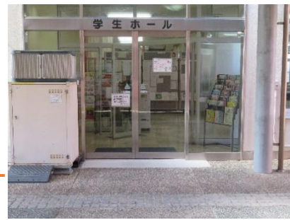
学生ホール入口 自動ドア
