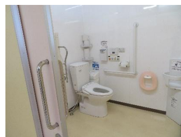
多目的トイレ 内部
